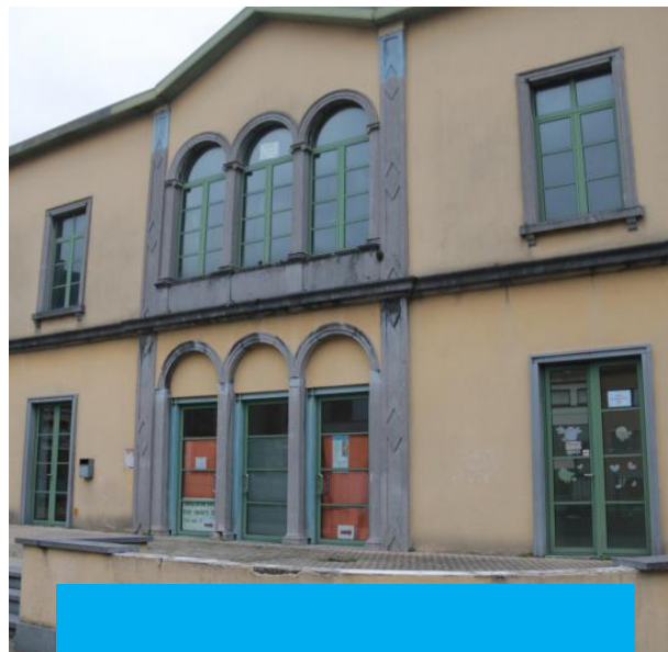
Travaux divers (menuiseries, peinture, façade...)
